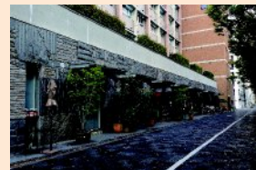
御池通に面した賑わい施設
