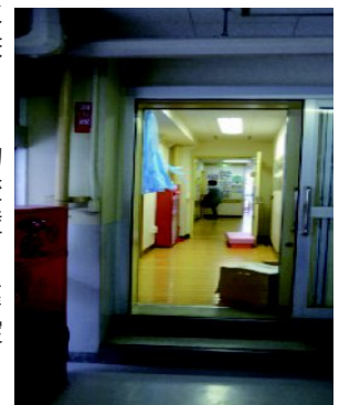
水回りのために床を高く整備するとともに、中学校との間に避難用の扉（防火扉）を設置
