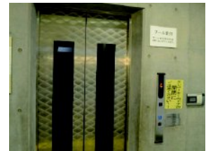
プール専用のエレベーター
