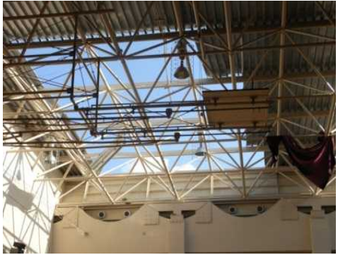
屋根材の破損
