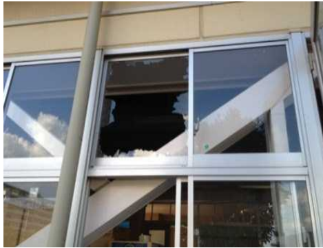
強化ガラスの破損
