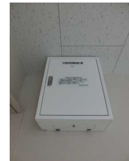
写真：災害時特設公衆電話取付端子 (王子小学校・王子桜中学校)
