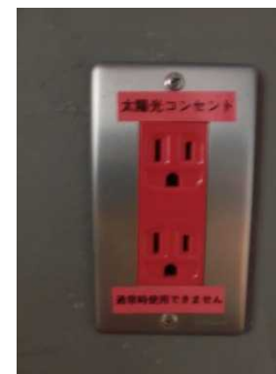
写真：太陽光発電の自立運転時に利用できるコンセント (王子小学校・王子桜中学校)
