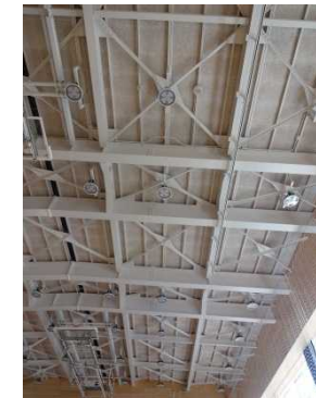
写真：体育館に省電力なLED照明を設置 (十条富士見中学校)
