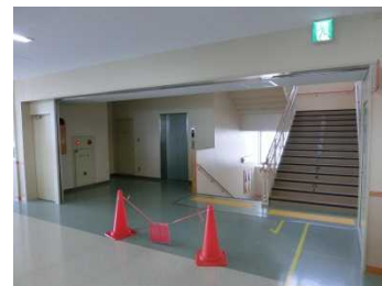
写真： 防火扉を閉めることにより、 避難所となる屋内運動場と 教室等の動線を分離 (汐入東小学校)
