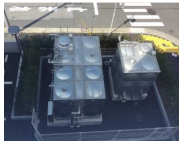
写真：大容量の受水槽 (松江小学校)
