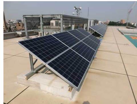
写真：自立運転可能な太陽光発電の設置 (十条富士見中学校)
