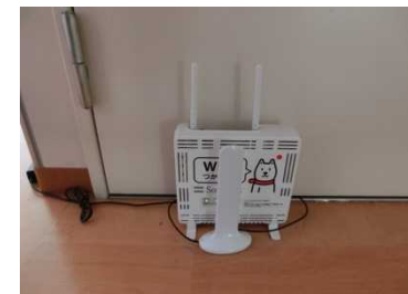
写真：無線LAN設備 (西新井小学校)
