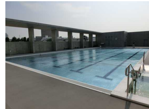
写真：屋上プールの水をマンホールトイレに利用 ( 十条富士見小学校 )
