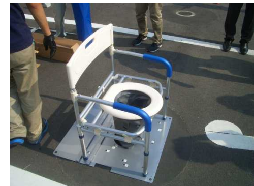
写真：マンホールトイレ（組立中の様子） ( 十条富士見小学校 )
