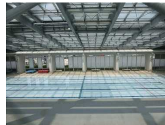
写真： 体育館屋上への プール設置による 断熱効果の向上 (王子小学校 ・王子桜中学校)
