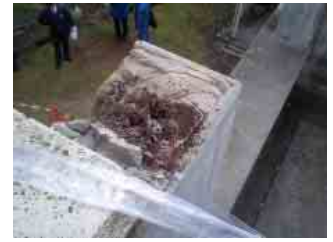
手すりの接合部 (支持部)
