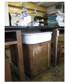
度重なる配管の破損
