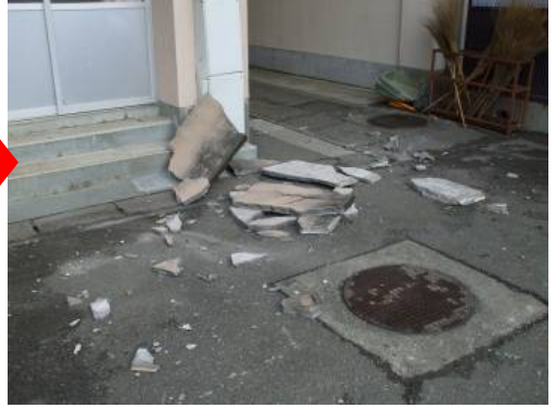
コンクリート片が落下(築31年)
