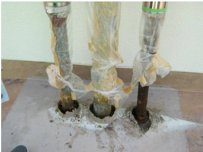
雨水の浸食により消防用鋼管が腐食 (築38年)
