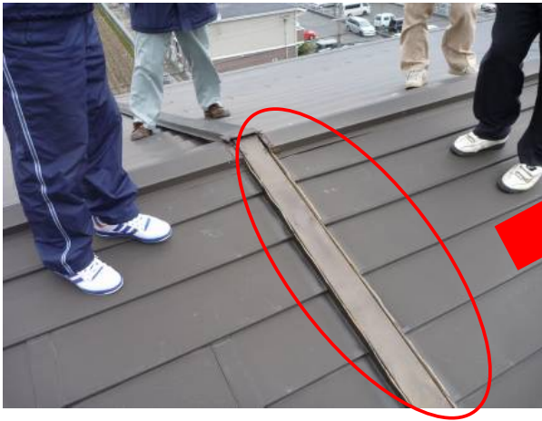
屋根材の一部が強風により剥離 (築26年)
