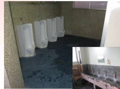
トイレの老朽化による臭気
