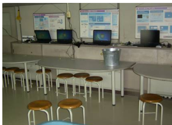
雨漏りによりコンピュータが一部破損
