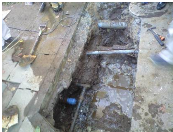
屋外の消火管の破裂。消火栓が使用できなくなり、一時的に消火器で対応
