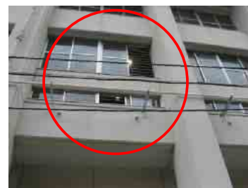
障子の落下箇所
