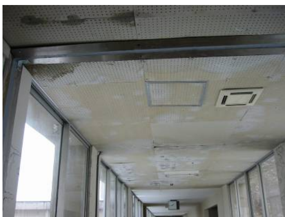
雨漏りにより天井が劣化(築31年)
