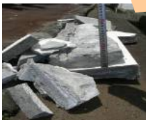
老朽化により モルタルが落下
