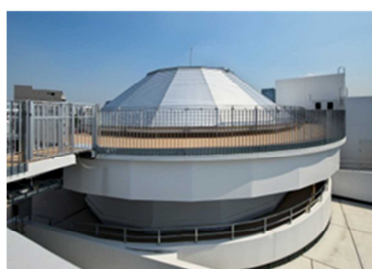
602 幅広い年代に利用されている 603 文化センターのプラネタリウム 604 (品川区立第一日野小学校)
