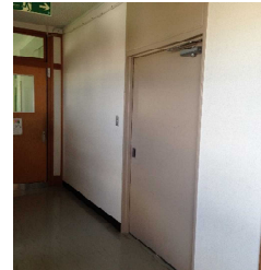
階段前に扉を設置し施設を分離
