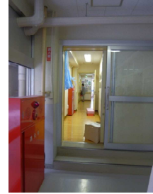
水回りのために床を高く整備するとともに、中学校との間に避難用の扉(防火扉)を設置
