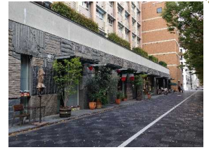
御池通に面した賑わい施設
