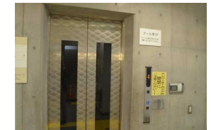
プール専用のエレベーター
