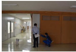
学校開放部分とそれ以外の部分を区分する扉
