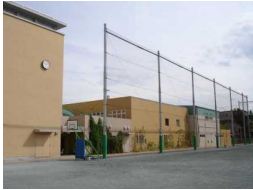
新BOP室の入口は校庭側に設けられている
