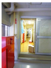
水回りの整備のために床を高くするとともに、 中学校との間の扉を設置
