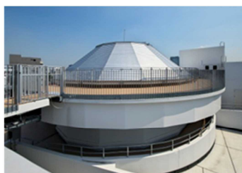
幅広い年代に利用されている文化センターのプラネタリウム (品川区立第一日野小学校)
