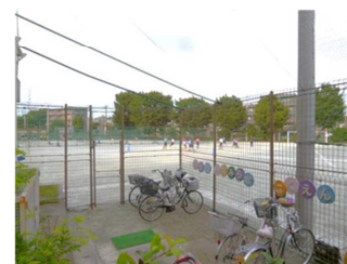
中学校校庭との境界に 防球ネットを整備
