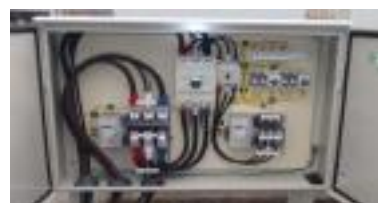
発電機の取付口 （江戸川区提供）
