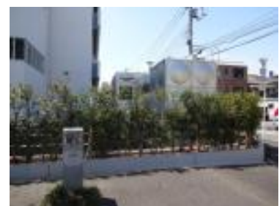
地震発生時には濁った水が入って こないように受水槽のバルブを閉め、 飲料水として使用 (東京都江戸川区立松江小学校)
