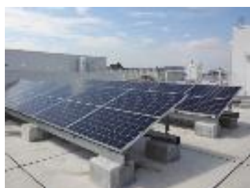
自立運転可能な太陽光発電設備
