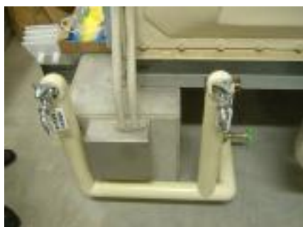
受水槽への蛇口の設置
