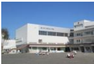
2階の屋内運動場と屋外階段
