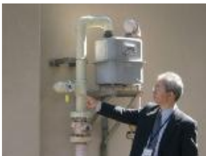
LP ガスから都市ガスへの変換器の取付口
