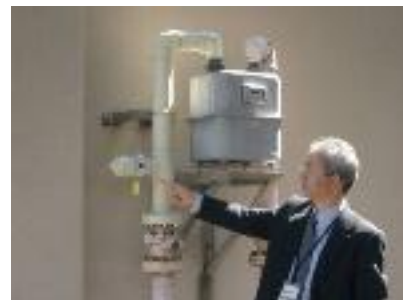
都市ガスエリアにおいても災害時には LPガスを使えるよう、LPガス変換器の 取付口を整備(新潟県長岡市) (長岡市教育委員会提供)
