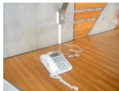
屋内運動場への電話回線の設置
