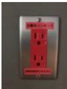
太陽光発電の自立運転時に利用できるコンセント (東京都北区立王子小学校・王子桜中学校)
