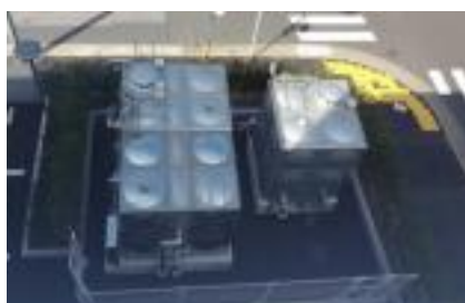
大型の受水槽
