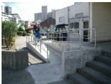
スロープの設置
