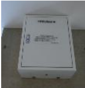
特設公衆電話取付端子 (東京都北区立十条富士見中学校) 電話は備蓄倉庫等に保管しておき、避難所開設時に使用。
