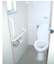
②屋内運動場 トイレの洋式化
