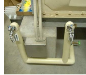
④受水槽への蛇口の設置
