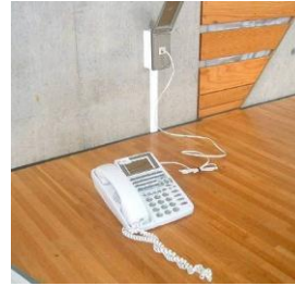
③屋内運動場への 電話配線の設置
