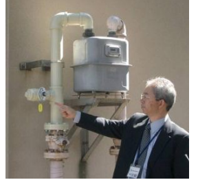
⑤ガス変換の接続口
