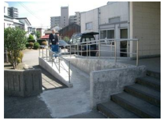
①スロープ整備
