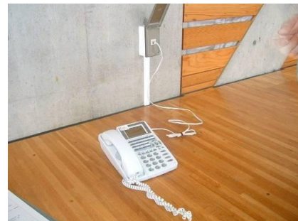
③屋内運動場への電話回線の設置
