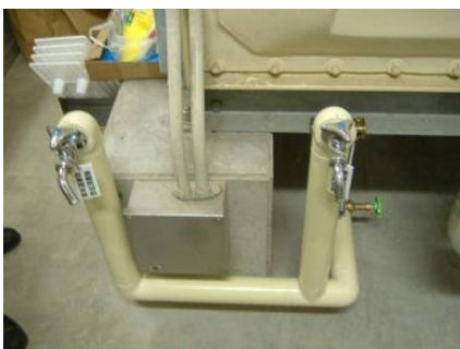
④受水槽への蛇口の設置
