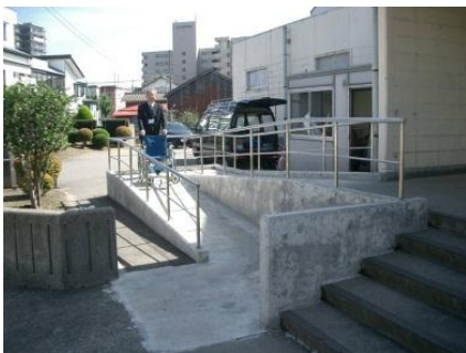
①スロープの設置
