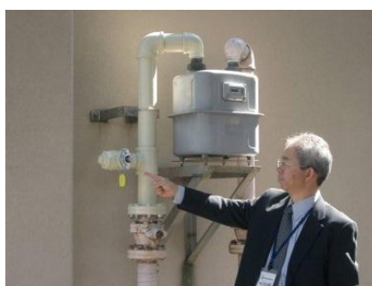
⑤LP ガスから都市ガスへの変換器の取付口
