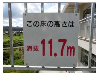
屋外避難階段に設けた各階の標高表示
