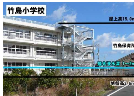
屋外避難階段(竹島小学校)
