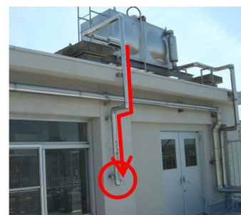
受水槽に蛇口を設置（名古屋市）
