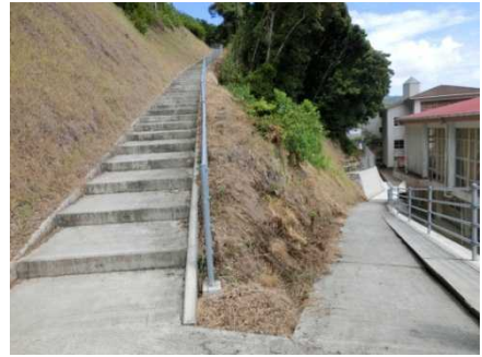
避難経路の踊り場（左側は階段、右側はスロープ）
