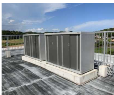
屋上の備蓄倉庫（竹島小学校）
