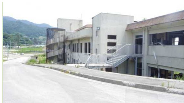
校舎 2 階と市道をつなぐ屋外非常用通路
