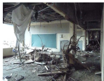
津波の水圧により壁が喪失した教室
