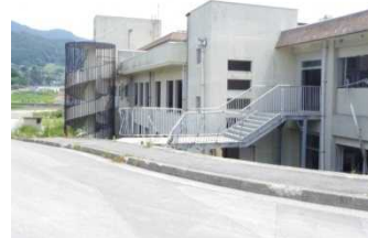
2 階と市道をつなぐ屋外非常用階段
