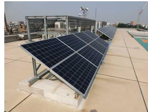
写真：自立運転可能な太陽光発電の設置
