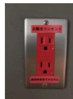
写真：太陽光発電の自立運転時に利用できるコンセント
