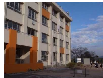
耐震化対策として、校舎東側各階2教室分を減築
