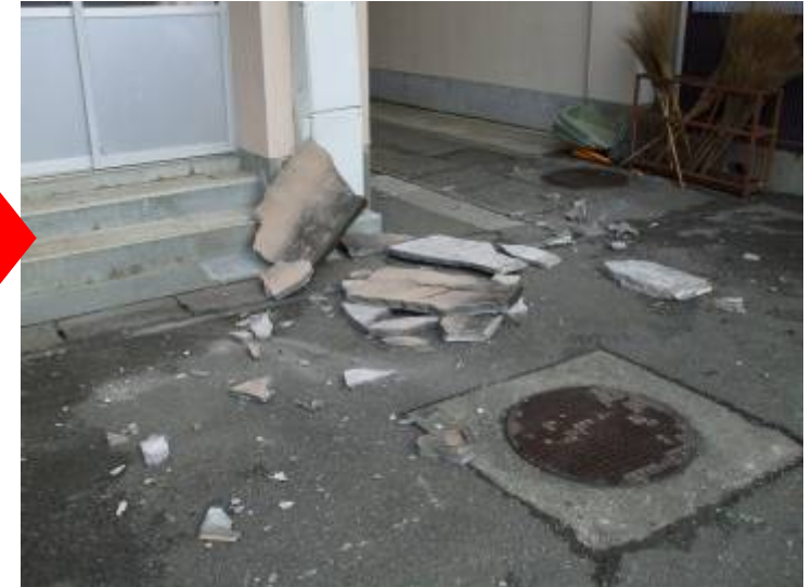
モルタル片が落下(築31年)
