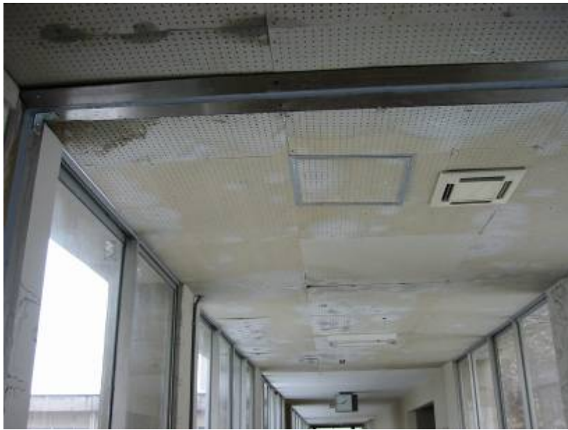
雨漏りにより天井が劣化(築31年)
