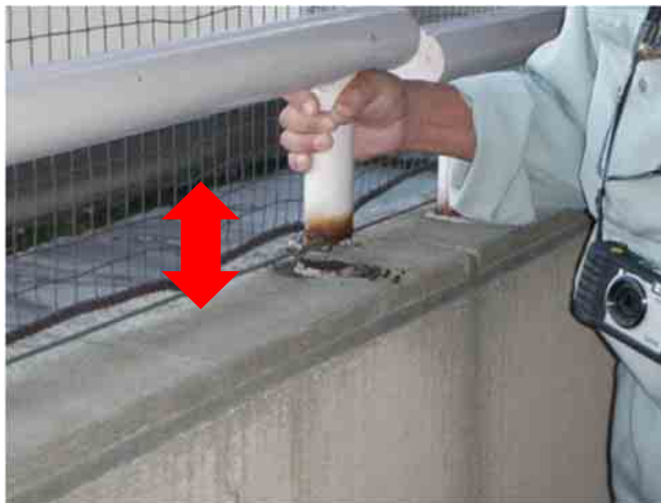
腐食の進んだ手摺が、多数の児童 が一斉にぶらさがった際に破損
