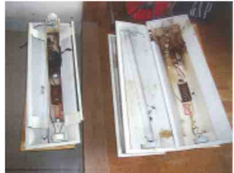
照明安定器が破裂(築41年)
