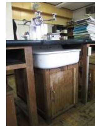
度重なる配管の破損
