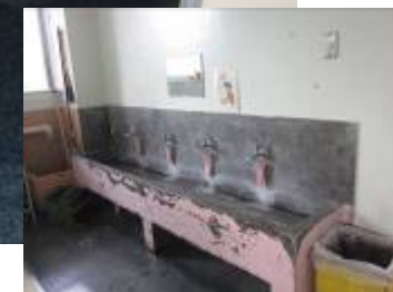
トイレの老朽化による臭気
