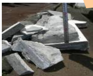
老朽化により モルタルが落下
