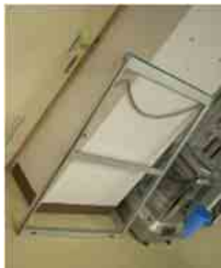
落下した障子
