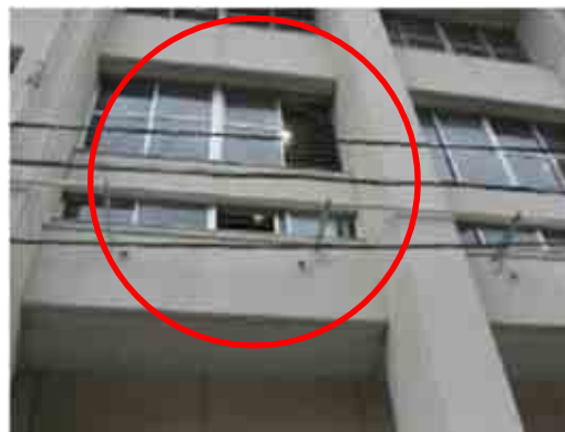
障子の落下箇所
