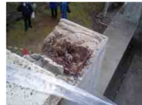
手すりの接合部 (支持部)
