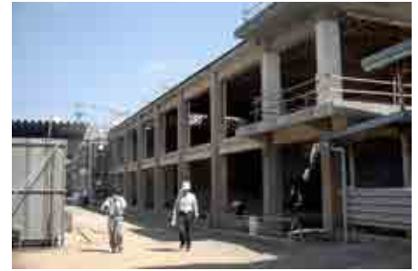
図4 改修中の風景
