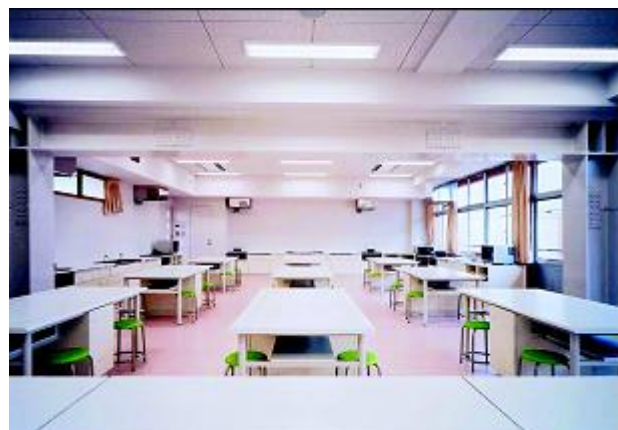
図4 教室の界壁を撤去した家庭科教室 (H型鉄骨で補強済み)
