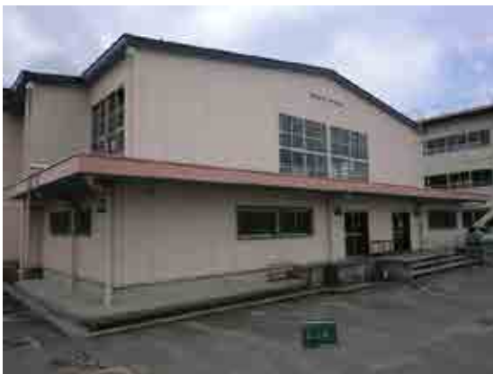
図1 改修前の屋内運動場
