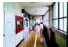
改修前の廊下
