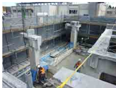
図2 ワイヤーソーイング工法での減築
