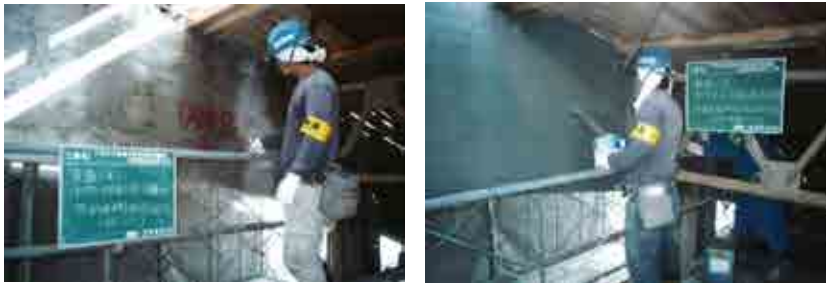
図3 中性化対策（左：アルカリ性付与材塗布 中央：中性化抑制材塗布）
