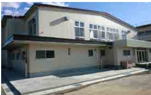
図2 改修後の屋内運動場
