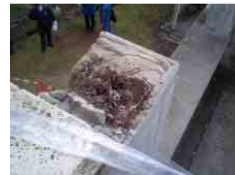
手すりの接合部 (支持部)
