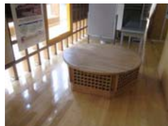
アースチューブ吹き出し口(押原小)
