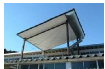
実習棟に設置されたシステム(掛川工高)
