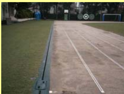
スリット側溝の設置(蓮根二小)
