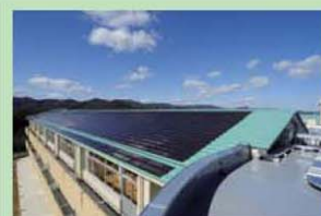
太陽光発電設備の設置
