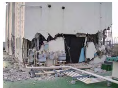
東北大学（塔屋外壁の破壊）
