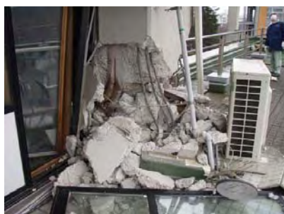
東北大学（柱の破壊）
