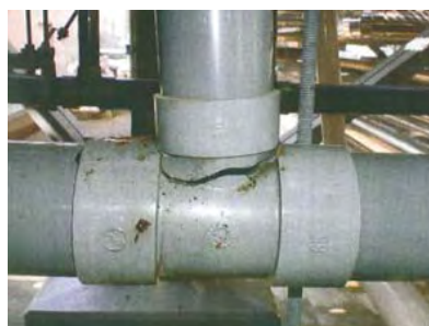
筑波大学（排水管の破損）
