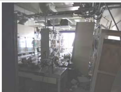
東北大学（実験機器等の破損）
