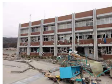
東京大学（津波による建物等の損壊）
