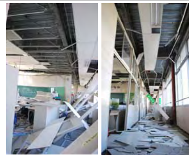
茨城大学（天井材の落下等）
