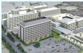
京都大学 医学部附属病院 積貞棟
