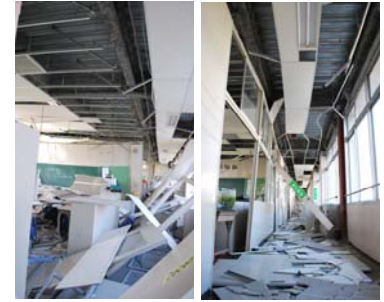
茨城大学（天井材の落下等）
