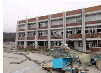
東京大学（津波による建物等の損壊）
