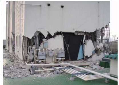
東北大学（塔屋外壁の破壊）
