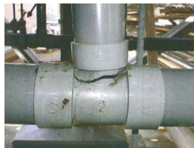
筑波大学（排水管の破損）
