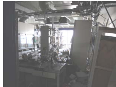
東北大学（実験機器等の破損）
