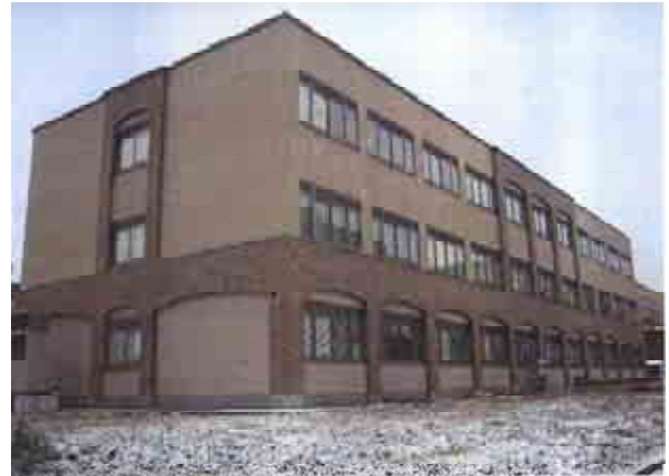
整備後(老朽再生整備の際に、外装等を改修)
