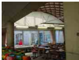
教室の天井面を工夫（木の格子ボルト天井）している例
