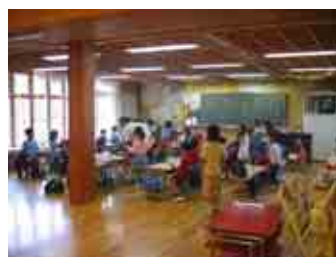
教室の天井面を工夫（格子）し低くみせている事例
