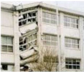
はりのせん断破壊(鉄筋コンクリート造)
