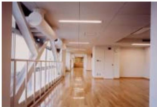
鉄骨ブレースを設置して耐震補強した例
