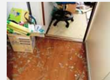
3階室内の壁に突き刺さった木片と床に散乱したガラス (引用:防災システム研究所HP)
