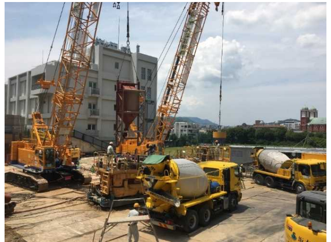
杭工事施工状況
