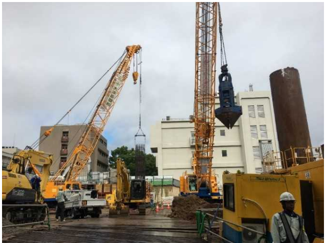
杭工事施工状況
