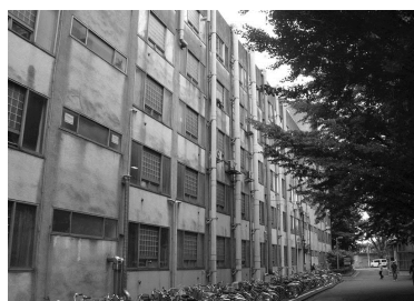
▲老朽施設の外観（経年48年）
