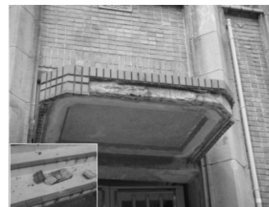
▲外壁タイルの剥落
