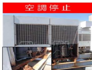
■空調機 経年23年 内部部品が腐食したため、温度調節ができない状態。
