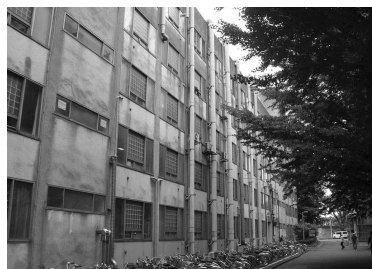
▲老朽施設の外観（経年48年）
