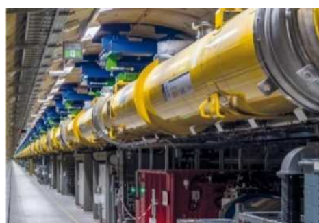
直線加速器のモジュール
