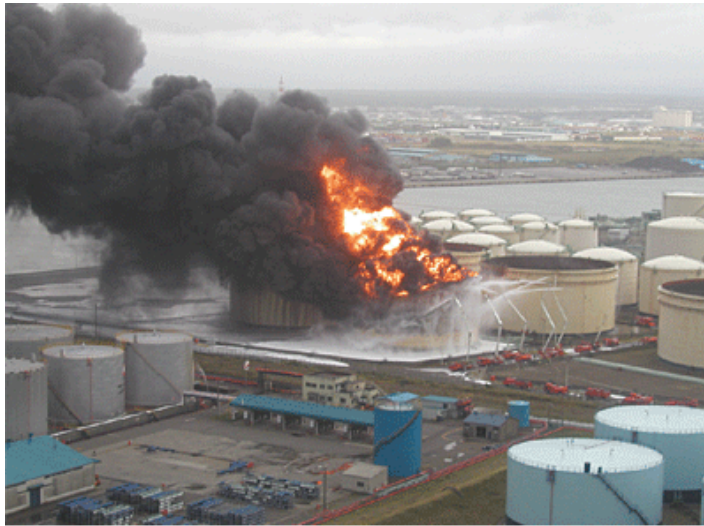
屋外タンク全面火災の状況
