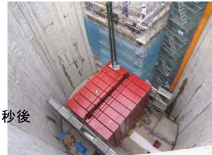
敷地内ニュートリノ検出器(建設中)
