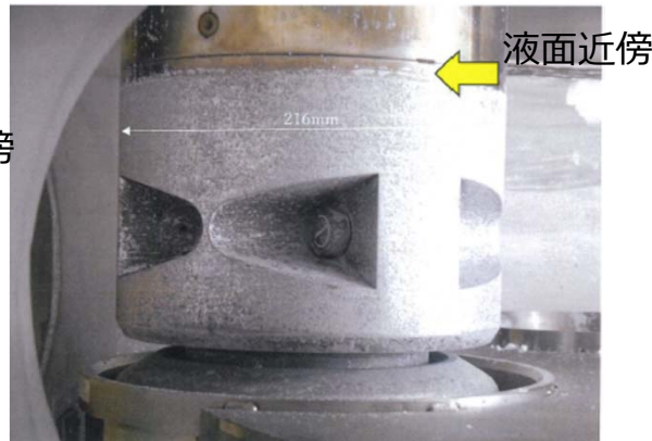
本体Aグリッパの液面近傍のNa化合物付着状況
