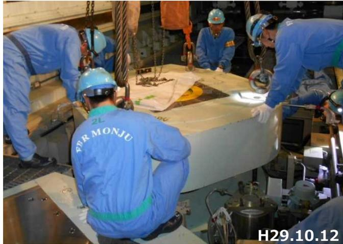
・水中台車床ドアバルブ取外し作業状況
