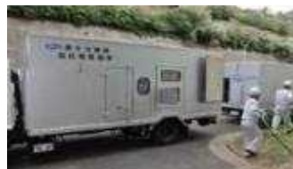
電源車接続訓練
