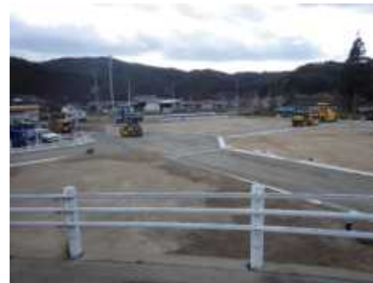
「災害公営住宅」の建設予定地
