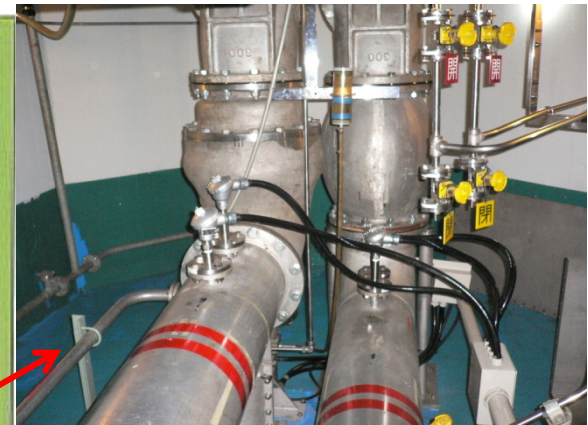
制御棒駆動装置
