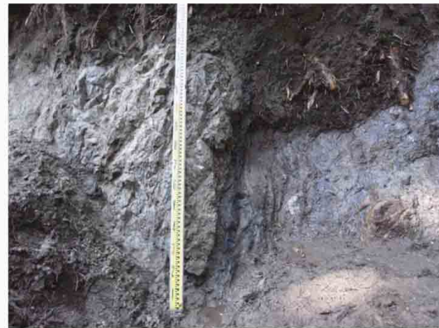
断層部の全景
