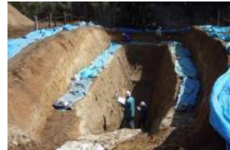
トレンチ調査
