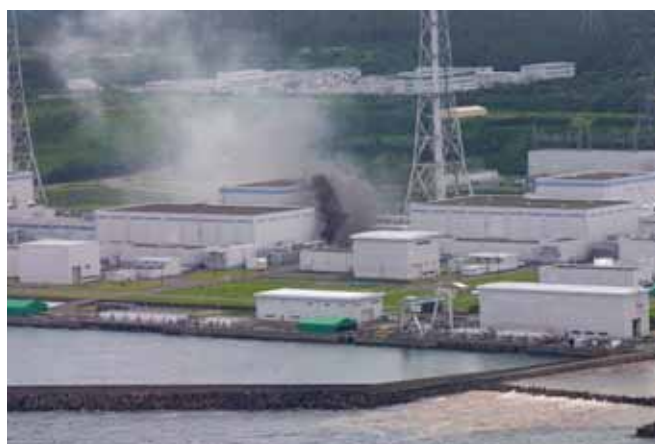
【黒煙を上げる所内変圧器（3号機）】 （第九管区海上保安本部提供）
