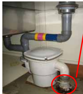
床板を剥がした後の状態
