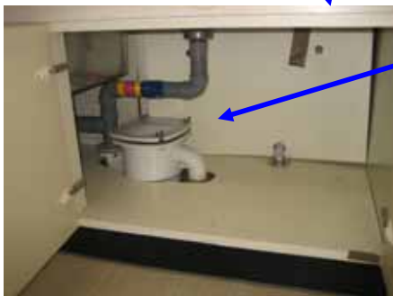
床板を剥がす前の状態
