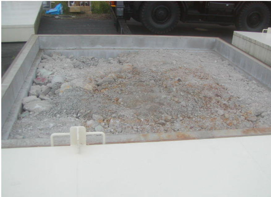
(コンクリートがらの保管状況)
