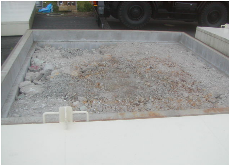
(コンクリートがらの保管状況)
