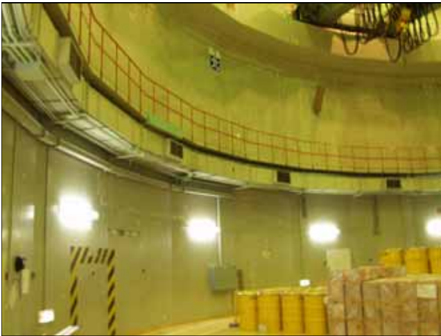
原子炉建屋北側壁面構造物
