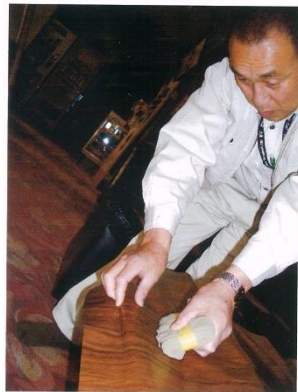
タックシートの乾式工法作業風景
