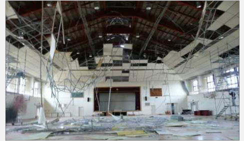
天井材が全面的に脱落した例
